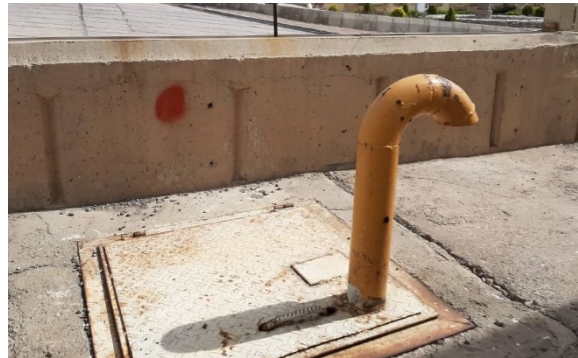
شکل ۱. ولوپیت و لوله عصایی در صنعت مورد مطالعه
